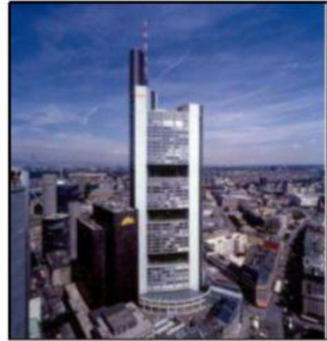
واجهة مبني برج البنك التجاري
